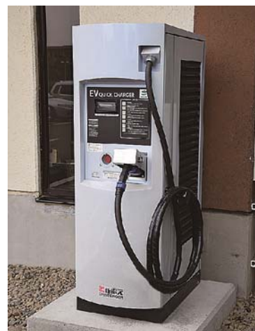
■学内に設置されたEV QUICK CHARGER (電気自動車用急速充電器)
